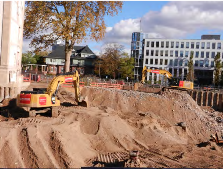
Die größte Baustelle in der Kölner City am 02.11.2021
